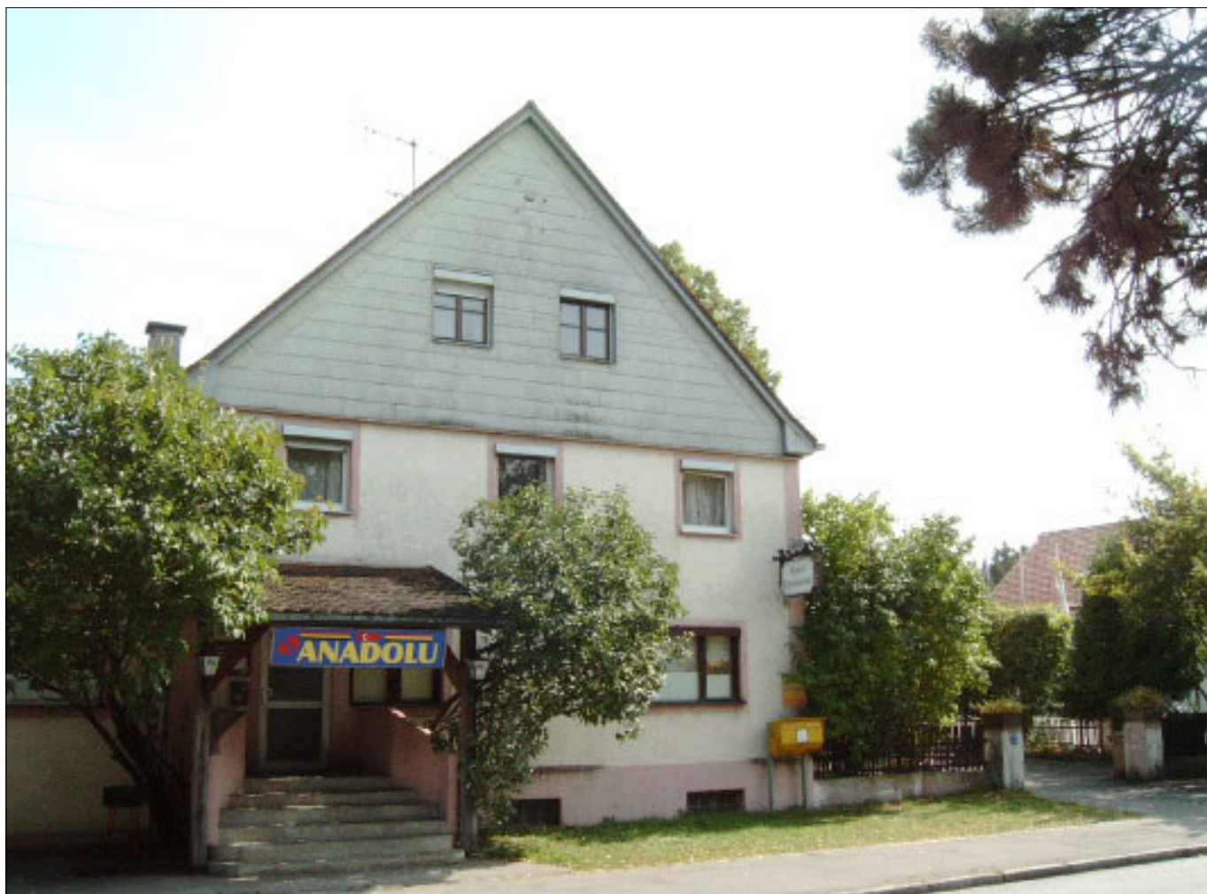
Eversbuschstraße 74: "Oberländer", dann Kaufhaus "Mantel", dann Hotel "Eversbuschhof" und nunmehr "Anadolu" (Foto: A. Thurner 2008)
