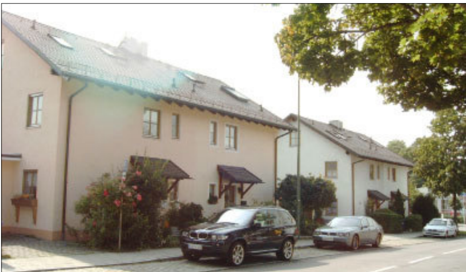
Neubauten auf dem Grundstück des "Kreitmair", nunmehr an der Allacher Straße 317-321 (Foto: A. Thurner 2008)
