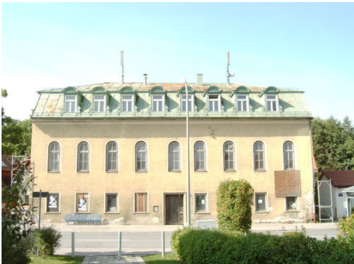
Das unbewohnte "Anwehrrer"- bzw. "Schwaigen"-Gebäude kurz bevor Beginn der Renovierung im Oktober 2008 (Foto: A. Thurner 2008)
